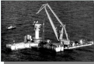
Montage des Aluminiumturms am 03.11.1965
